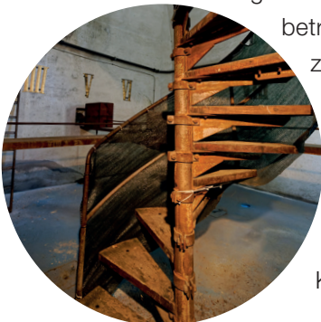
Kirchturm-wendeltreppe vor der Sanierung
